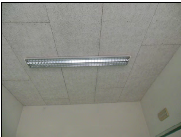
Fotografia 9 Controsoffitto del locale al piano terra della scuola secondaria di primo grado.
